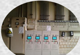
设备安装现场
